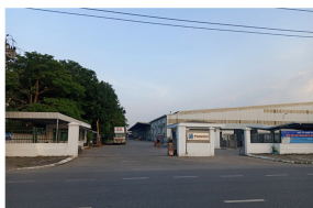
CÔNG TY PIAGGIO KCN Bình Xuyên, Bình Xuyên, Vĩnh Phúc
