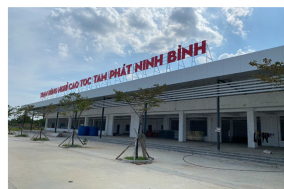
TRẠM DỪNG NGHỈ NINH BÌNH Km9+400 phía đông, Ninh Phúc, Ninh Bình
